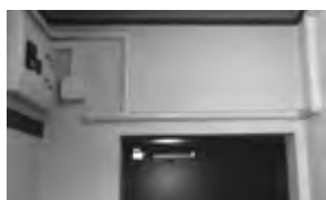
化粧力バー工法による露出配管
