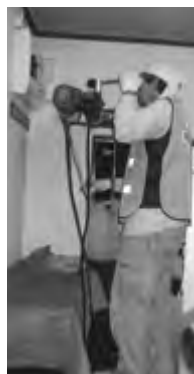
給水管貫通のための外壁穿孔工事
