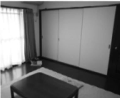
リビングと児童室との仕切りの襖も壁紙の色に合わせて取替えた。右側のドアはフローリングの色に合わせて塗り替えた
