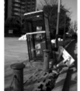
地面の隆起や地盤沈下で路面が割れ、電話ボックスは大きく傾いた。=新潟安
