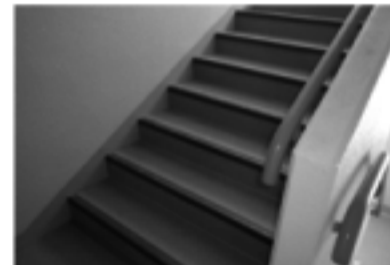
階段床樹脂シート貼り
