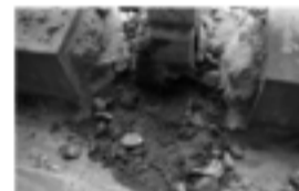
基礎調査でアルミ手すり支柱基部の腐食を把握
