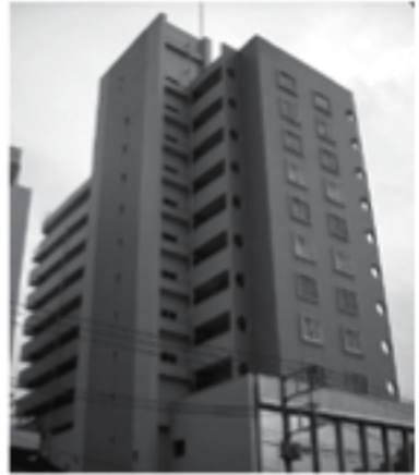
工事があった方南第一マンション
