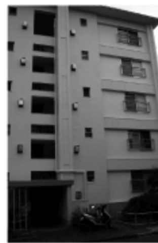
復旧後の罹災棟
