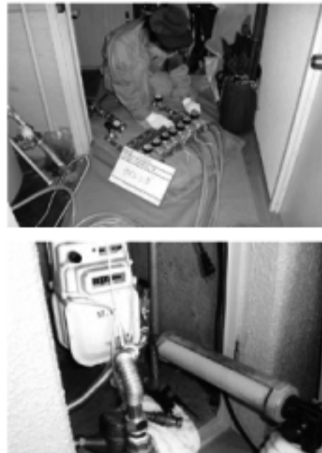
工事は作業&検査で進める
