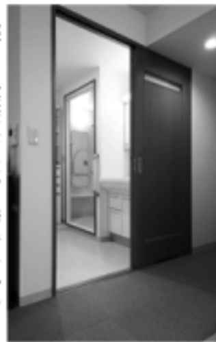
廊下との段差が無くなった洗面所入口。手摺りは福祉用具相談員と連携して設置
