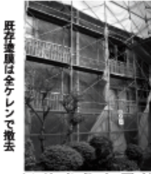
既存建物は全ケレンで撤去
