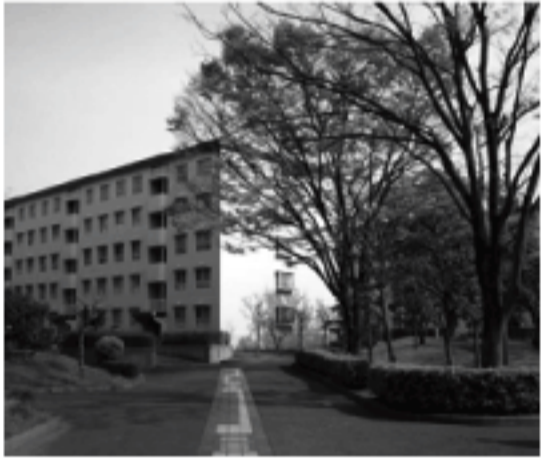
川越グリーンパークの他工事、外壁は微弾性シリコントップ塗装(色は既存色にて仕上げ)、屋上はトップコートを遮熱塗料による保護。階段室は床面塩ビシート張り・照明器具交換、など。
