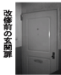
改修前の玄関扉
