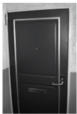
新品同様になった玄関扉
