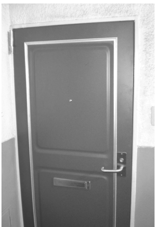
新品同様になった玄関扉
