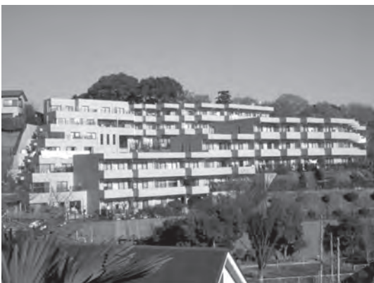
工事を終えた「保土ヶ谷月見台ガーデンハウス」
