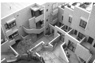
通路階段の手すり設置
