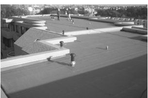
改修後の屋上防水
