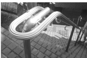
新設付加した手すり
