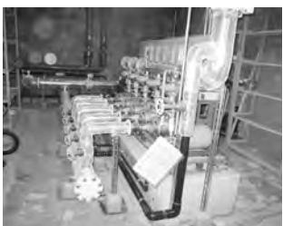
給水ポンプは5台新設した
