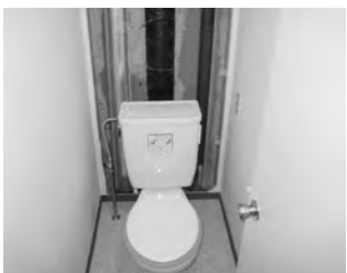
トイレを脱着して行ったトイレ内排水工事
