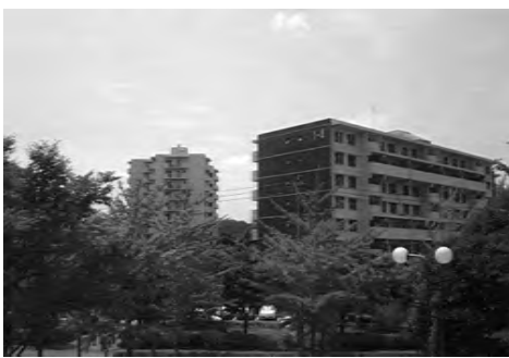
工事が完了した並木二丁目第一住宅
