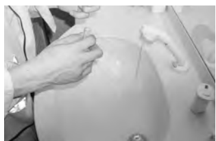
完工間近。通水(給水・排水確認)
