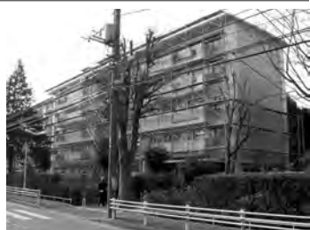
工事が行われた高塚団地
