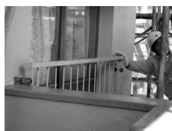
窓枠手摺を補助金具で補強
