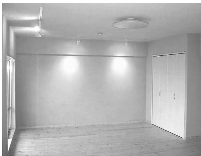
壁・天井を珪藻土で施工したリビング
