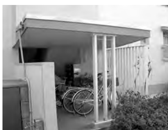
階段室玄関庇支柱補強
