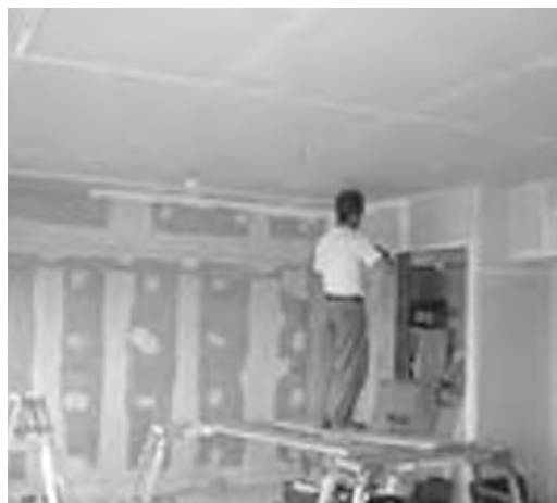
施工中の様子
