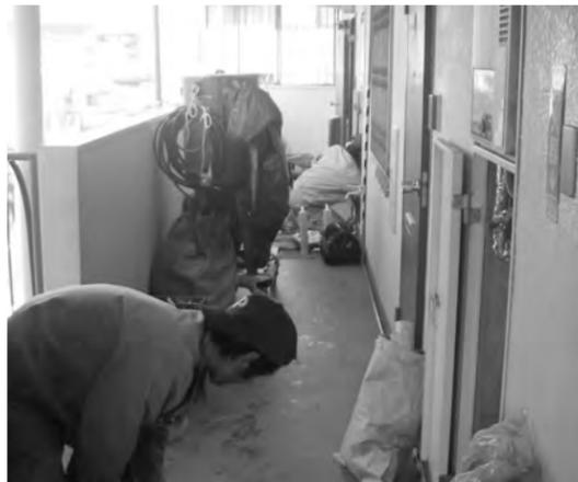
完成検査で管内圧力保持中、あと30分で水道が使える
